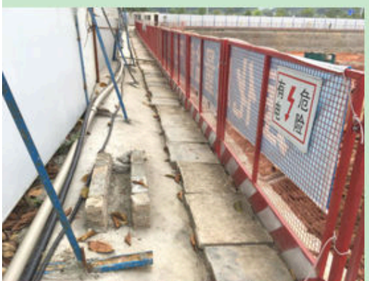
图 39 北地块基坑周边防护现状 9
