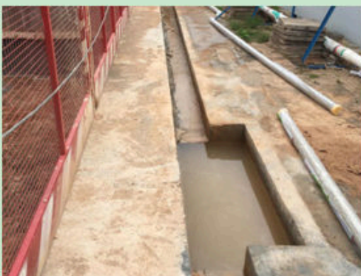
图 26 南地块基坑周边沉砂池现状 4
