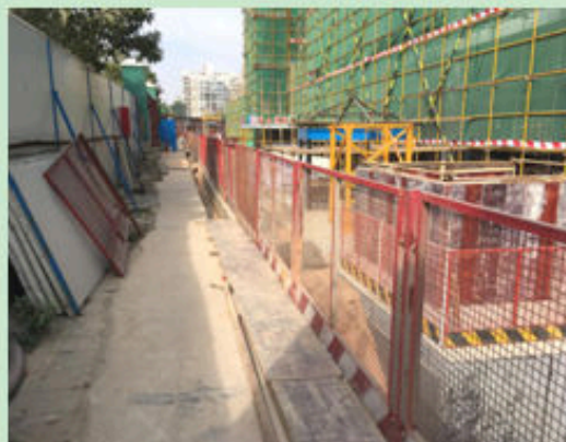
北地块建筑周边防护现状 4
