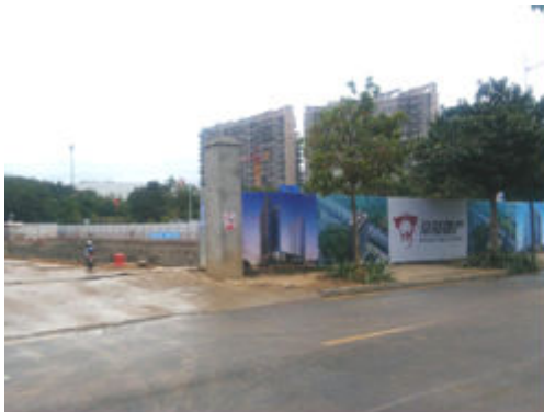
北地块出入口外周边现状
