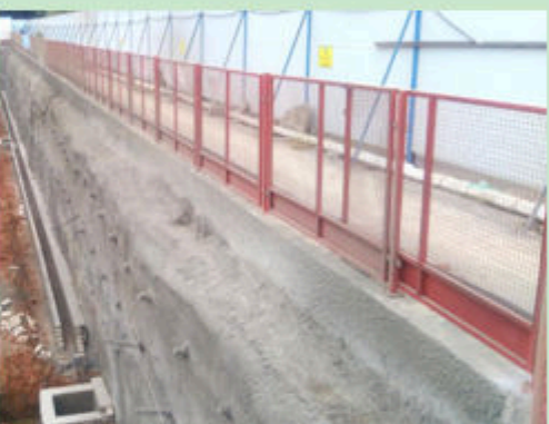
北地块坑底排水沉沙措施及边坡防护
