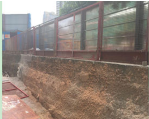
图 8 新施工围墙周边现状 2
