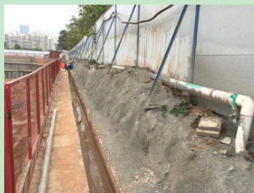
图 15 南地块基坑周边防护现状 5
