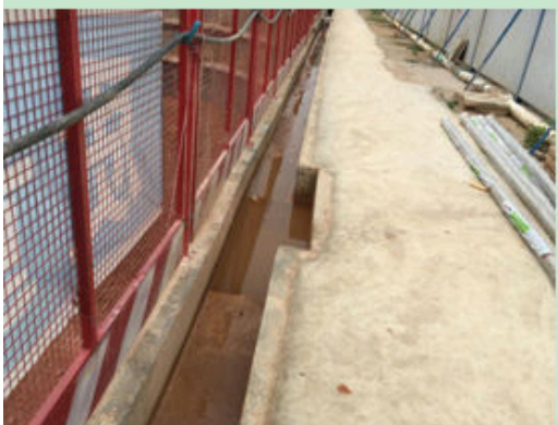
图 23 南地块基坑周边沉砂池现状 1
