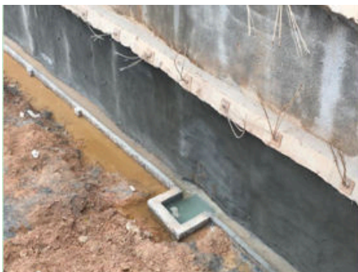
图 21 南地块坑底排水沉砂设施 2
