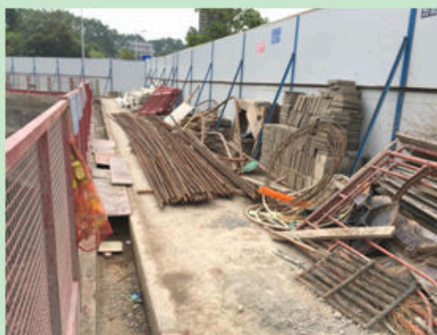
图 10 南地块部分围墙内侧现状
