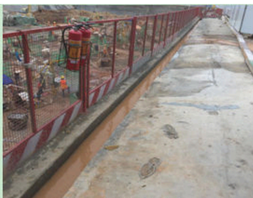
图 38 北地块基坑周边防护现状 8
