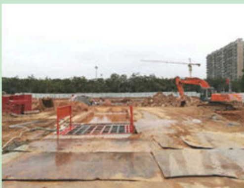
南地块洗车池及周边现状
