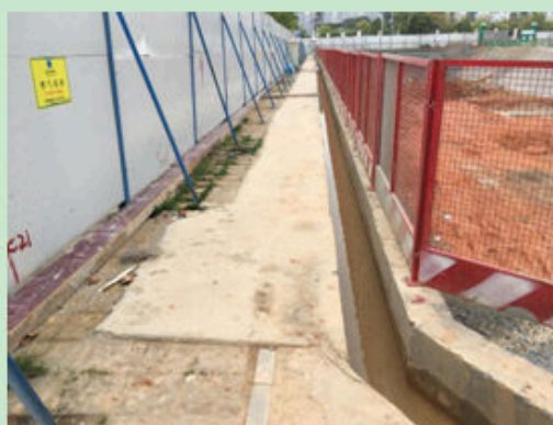
图 32 北地块基坑周边防护现状 2
