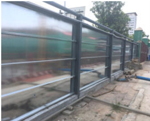
图 7 新施工围墙周边现状 1
