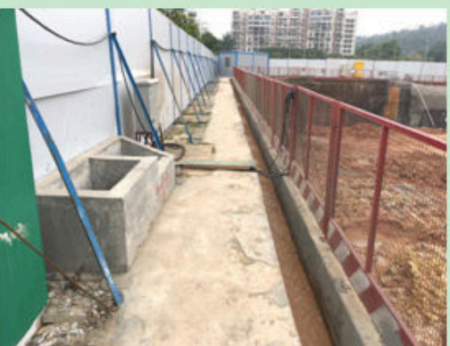
图 34 北地块基坑周边防护现状 4
