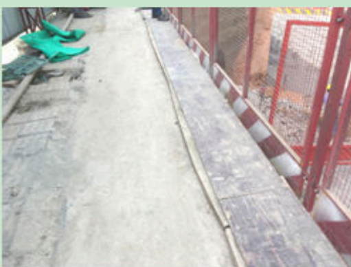
南地块基坑周边防护现状 4
