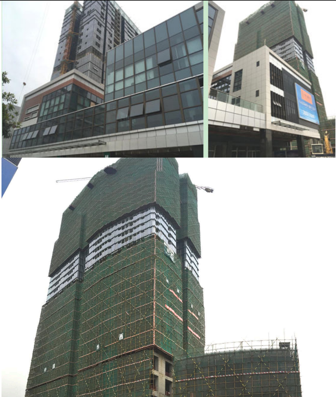
项目区各地块各阶段整体施工现状
