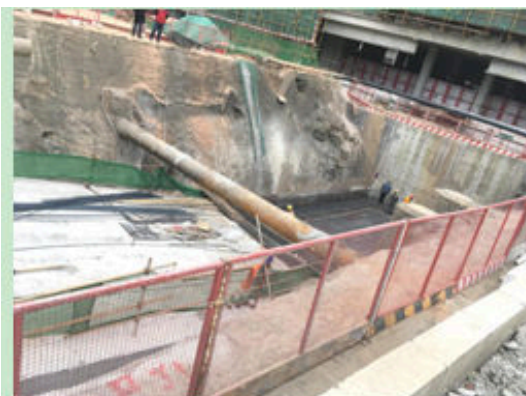
北地块管线施工区坡面硬化
