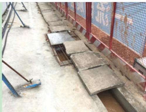
图 46 北地块基坑周边沉砂池 2
