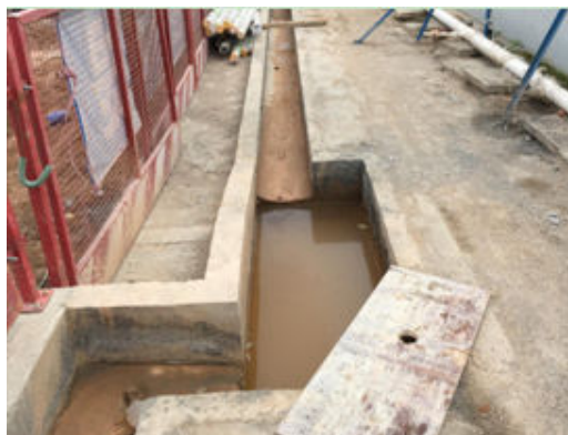
图 27 南地块基坑周边沉砂池现状 5
