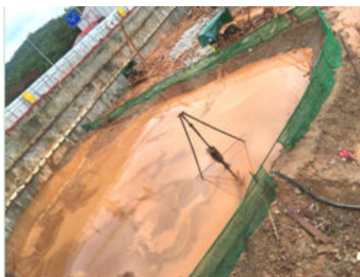
南地块坑底泥浆池周边现状
