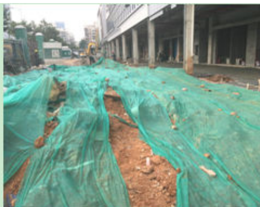
建筑回填施工面临时覆盖
