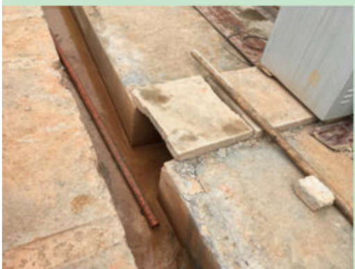
图 25 南地块基坑周边沉砂池现状 3
