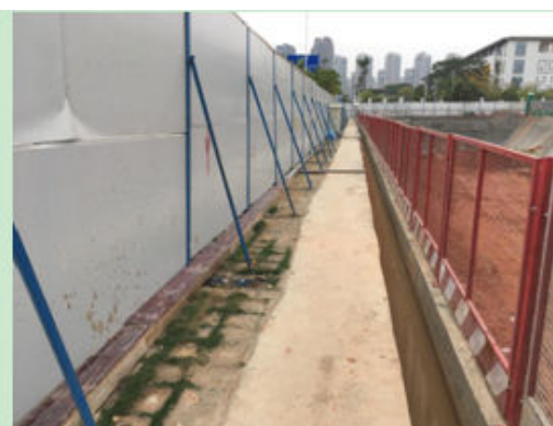
图 36 北地块基坑周边防护现状 6
