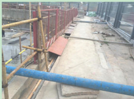
图 11 建筑施工区周边防护现状 1
