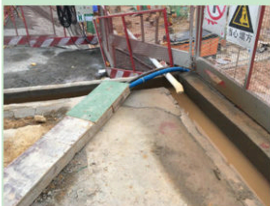
图 41 北地块基坑周边抽排水口 2
