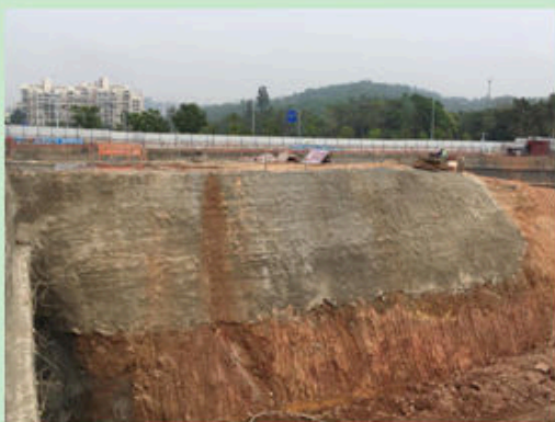
图 17 南地块出土坡道坡面硬化施工
