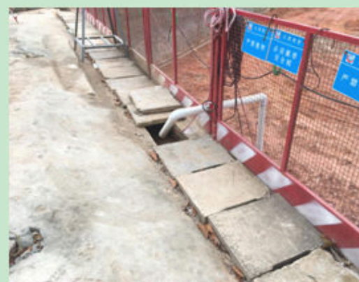
图 40 北地块基坑周边抽排水口 1
