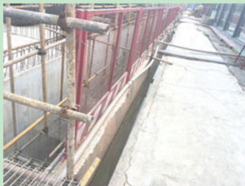
图 12 建筑施工区周边防护现状 2
