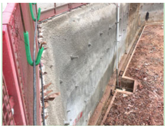
图 43 北地块坑底排水沉沙设施 1
