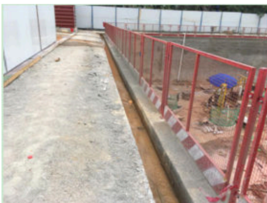
图 37 北地块基坑周边防护现状 7
