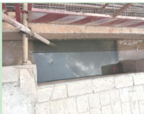
图 16 施工区周边部分沉砂池现状
