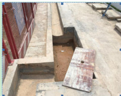
南地块基坑周边沉砂池现状 2
