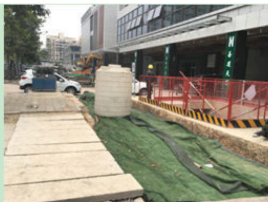
北地块建筑周边地表防护
