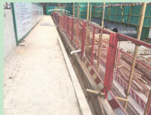
图 14 建筑施工区周边防护现状 4
