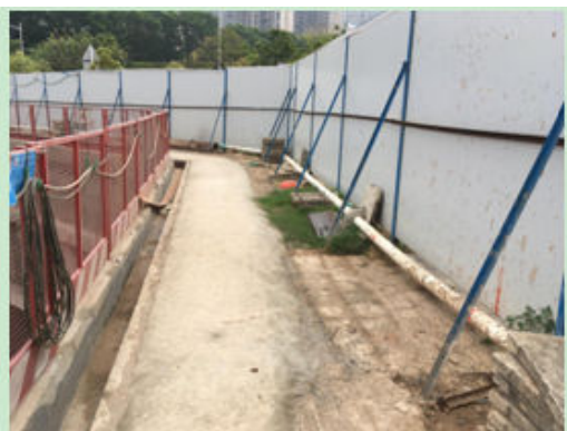
图 12 南地块基坑周边防护现状 2
