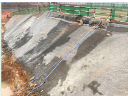
图 29 北地块基坑出土坡道坡面硬化
