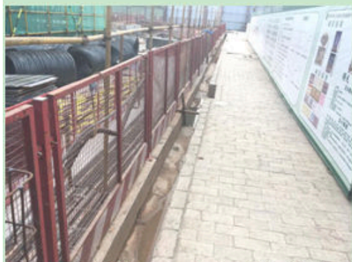
图 13 建筑施工区周边防护现状 3
