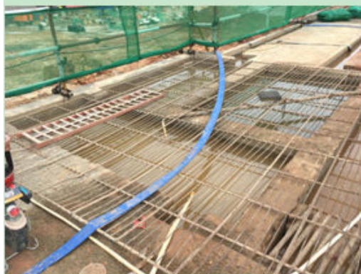
图 49 北地块现状多级沉砂池 2
