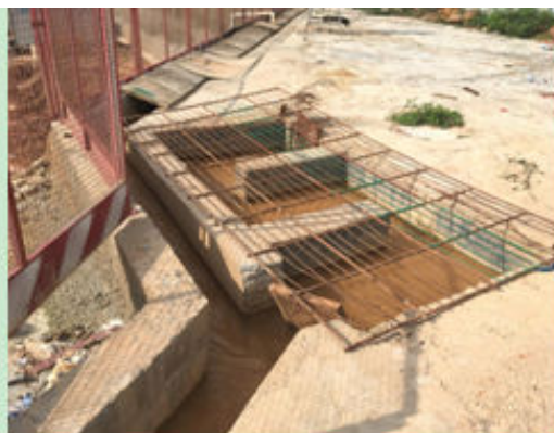
北地块现状多级沉砂池 3
