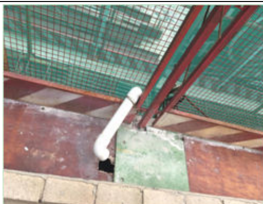
施工区周边部分抽排水口 1
