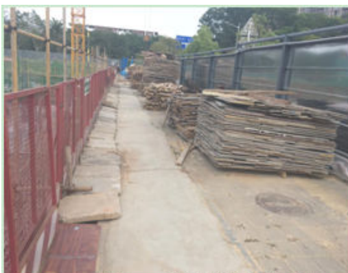
图 15 建筑施工区周边防护现状 5
