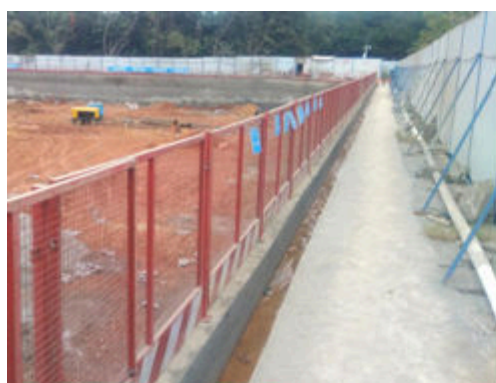
北地块坑顶周边硬化及排水 1
