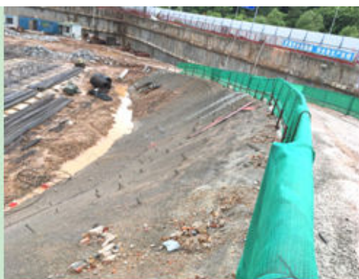
南地块基坑出土坡道硬化现状
