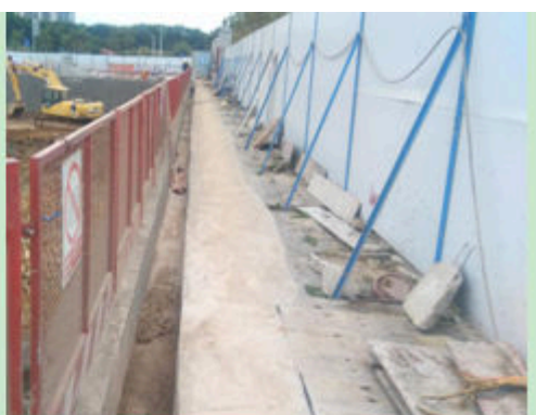
北地块坑顶周边硬化及排水 2
