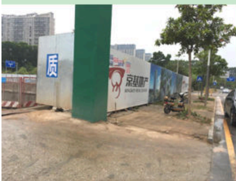
图 9 南地块部分围墙外侧现状
