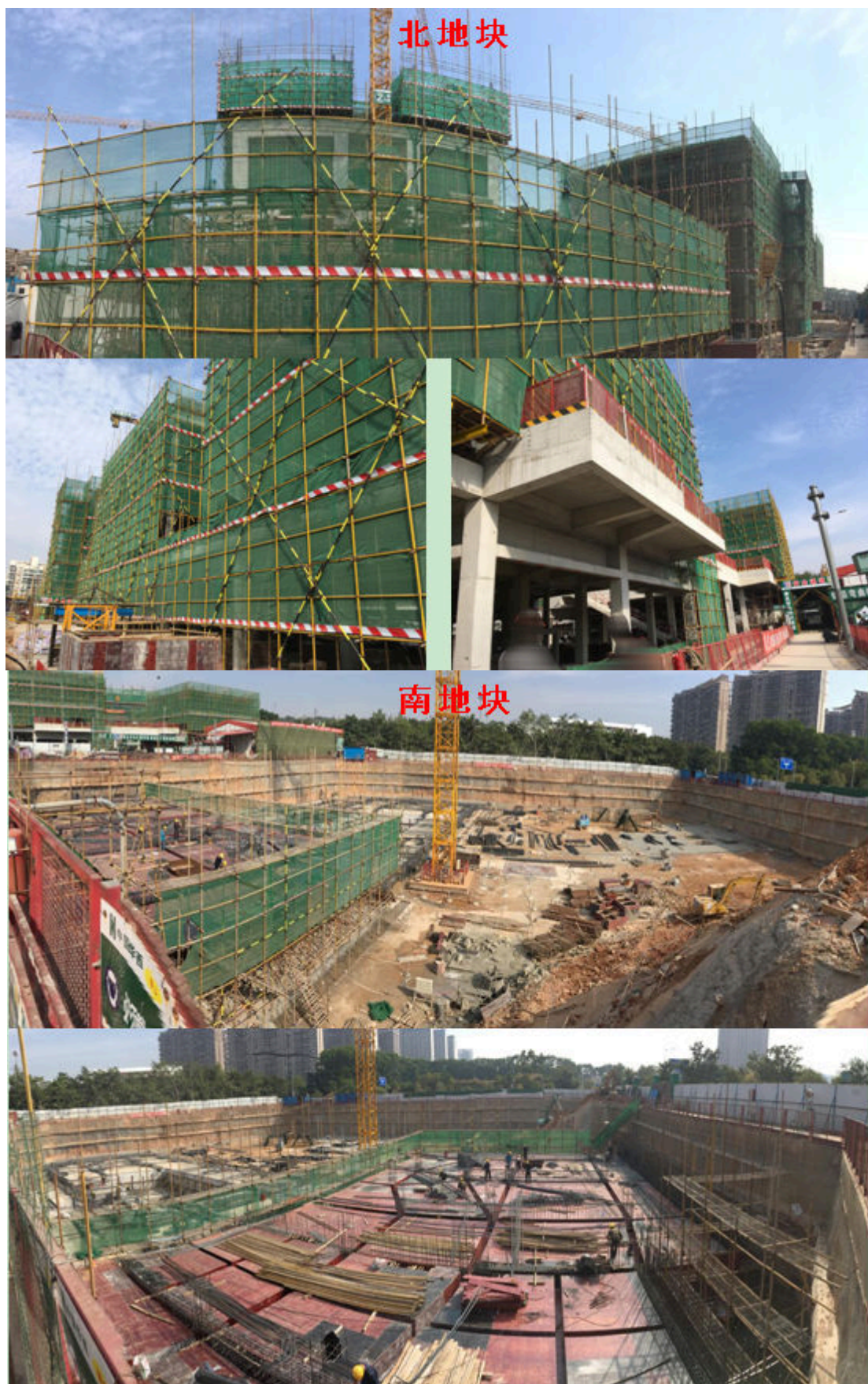
项目区各地块基坑各阶段整体施工现状
