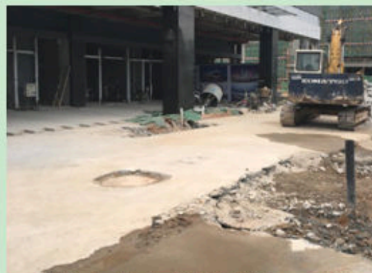
北地块建筑周边管线施工现状 2
