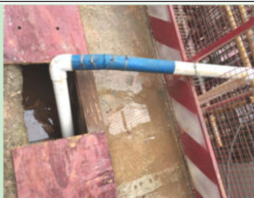
施工区周边部分抽排水口 2
