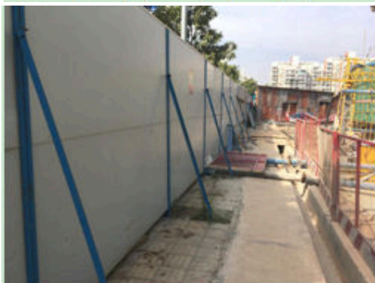
北地块建筑周边防护现状 1
