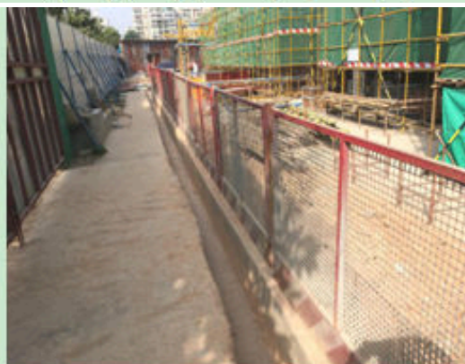
北地块建筑周边防护现状 2
