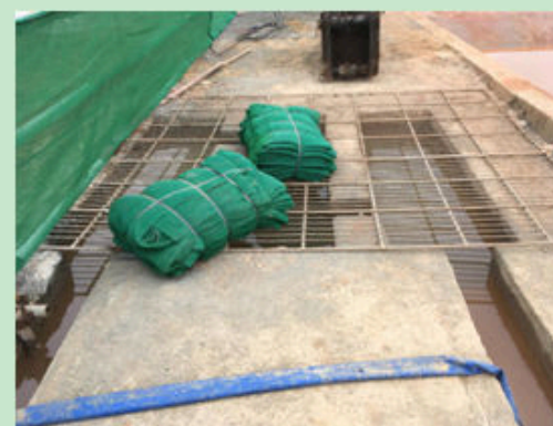
图 48 北地块现状多级沉砂池 1
