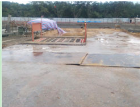
北地块洗车池及周边现状
