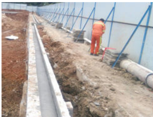
南地块基坑周边防护施工现状
