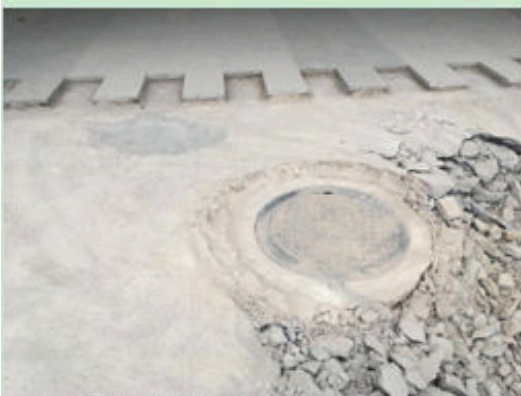
北地块建筑周边管线施工现状 1
