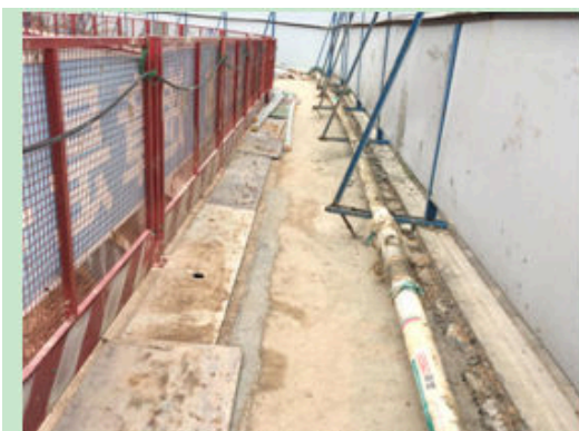
图 13 南地块基坑周边防护现状 3
