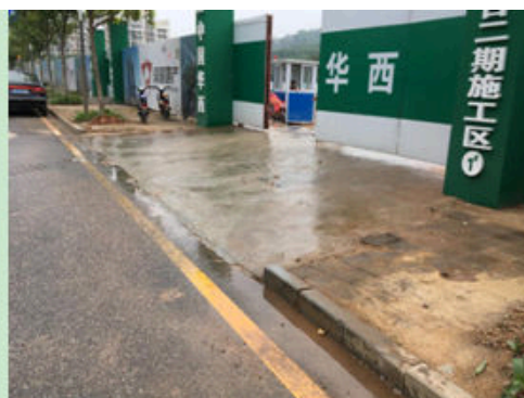
图 8 南地块出入口外周边现状
