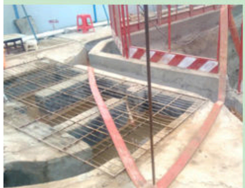
北地块基坑边多级沉砂池
