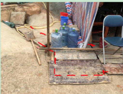
图 24 南地块基坑周边沉砂池现状 2
