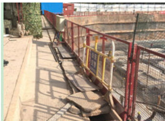
南地块基坑周边防护现状 1
