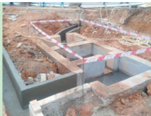
南地块新建成的多级沉砂池
