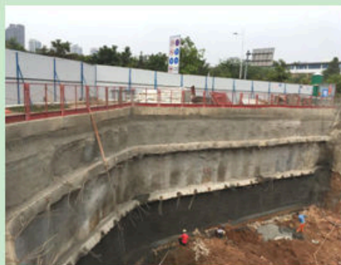
图 18 南地块部分基坑边坡支护现状
