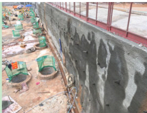
图 30 北地块部分基坑边坡支护现状
