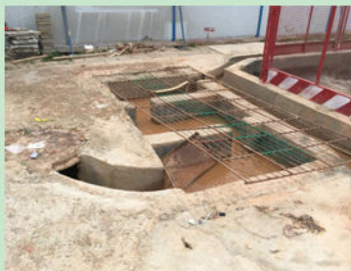
图 50 北地块现状多级沉砂池 3
