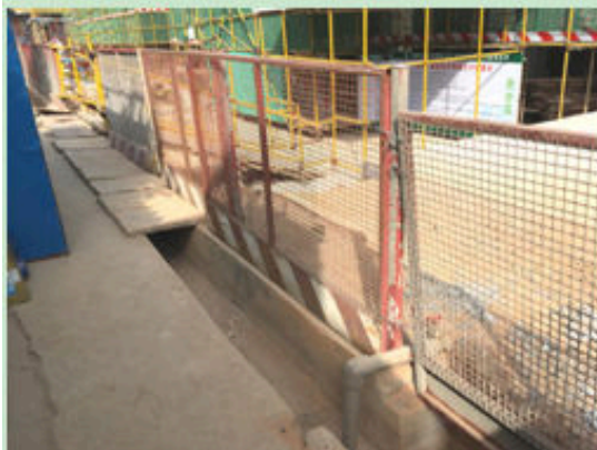
北地块建筑周边防护现状 3
