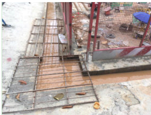
图 45 北地块基坑周边沉砂池 1
