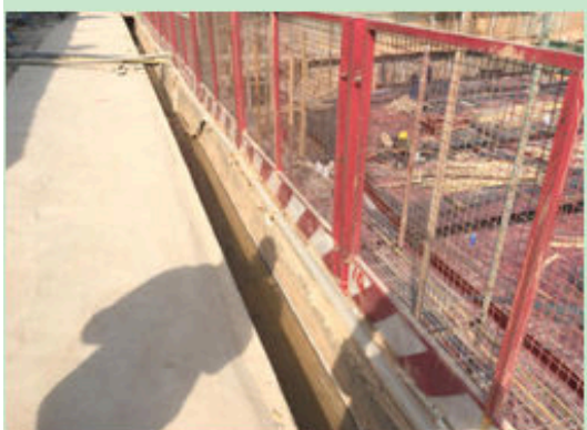
南地块基坑周边防护现状 3
