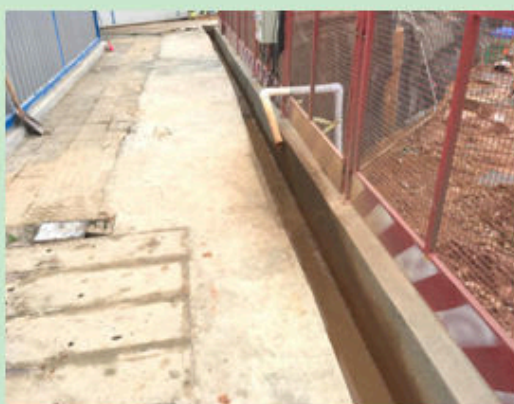
图 42 北地块基坑周边抽排水口 3
