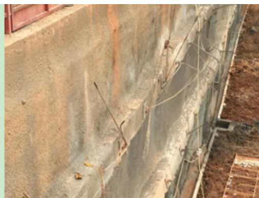
图 20 南地块坑底排水沉砂设施 1
