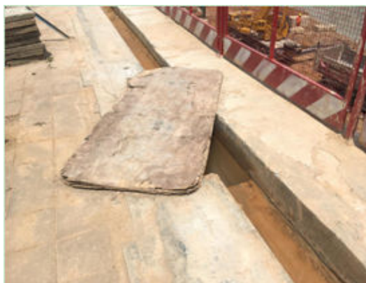
南地块基坑周边沉砂池现状 1
