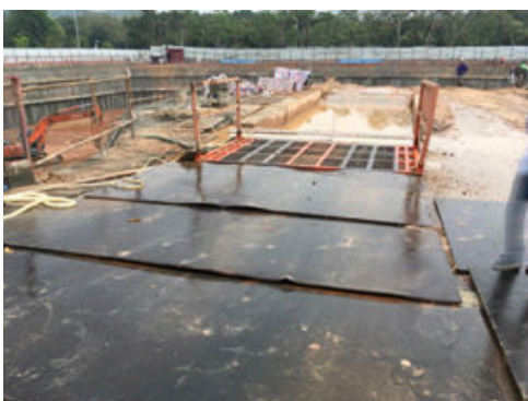
图 7 南地块出入口洗车池现状
