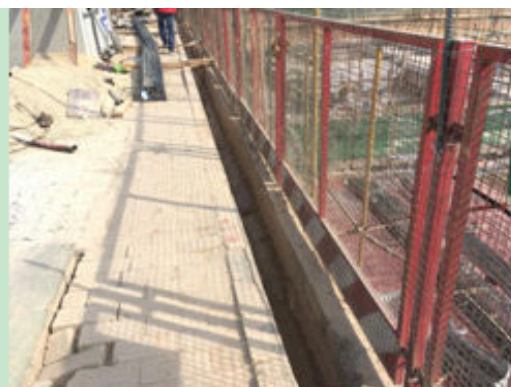
南地块基坑周边防护现状 2
