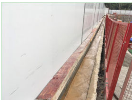
图 35 北地块基坑周边防护现状 5
