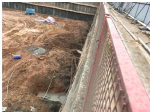
图 19 南地块坑内部分土质集水井
