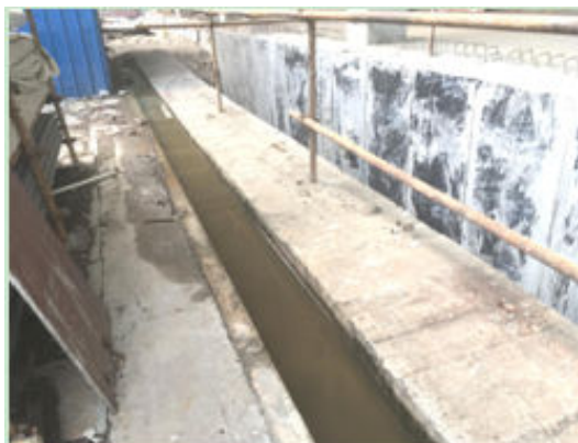
部分建筑周边排水沟现状
