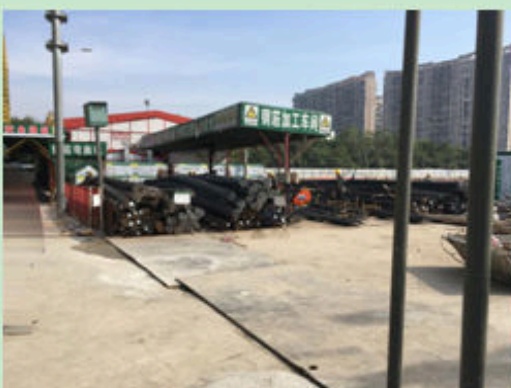
材料加工堆放区周边现状
