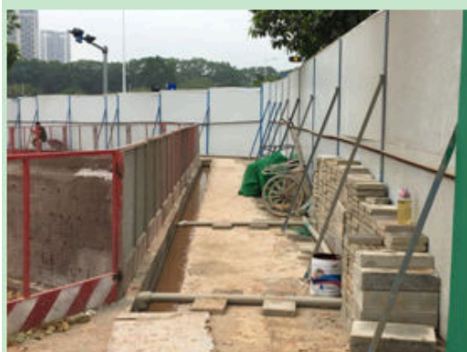
图 31 北地块基坑周边防护现状 1
