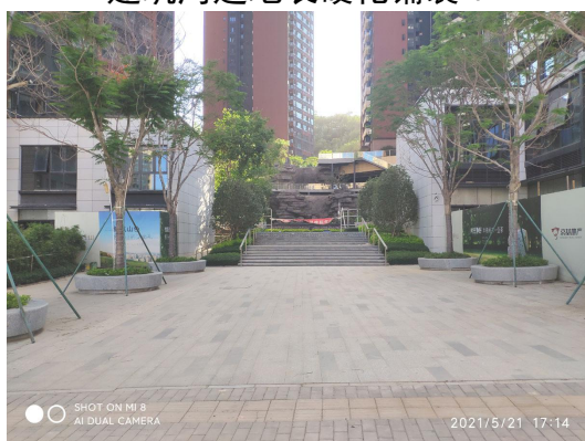
建筑周边地表硬化铺装 3
