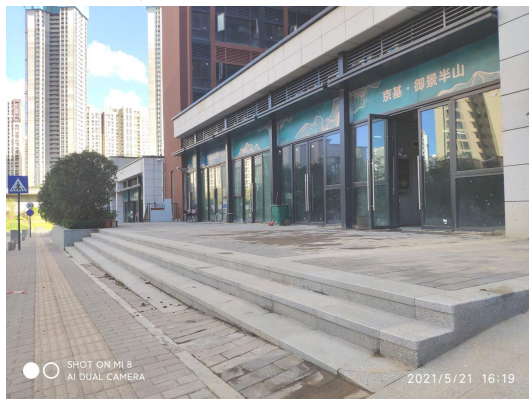
建筑周边地表硬化铺装 5
