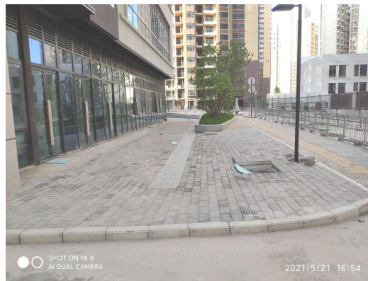
建筑周边地表硬化铺装 2
