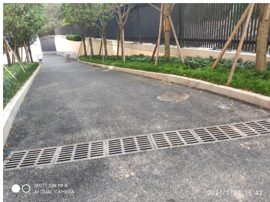
建筑周边地表硬化铺装 1
