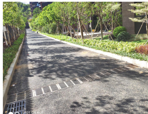
建筑周边地表硬化铺装 6
